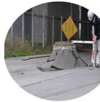
車道中央のマンホール
