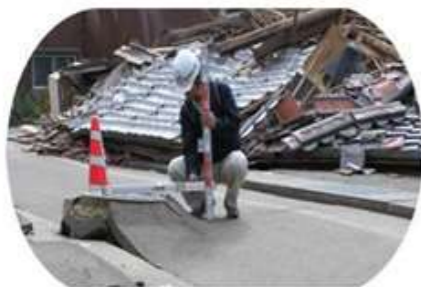
倒壊家屋とマンホール
